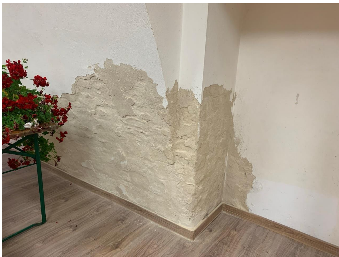
Odspojone tynki w jednym z pomieszczeń bastionu
