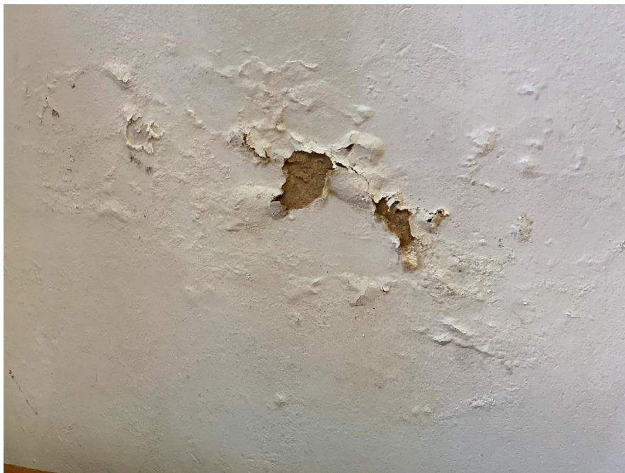
Wysolenie na powierzchni tynku
