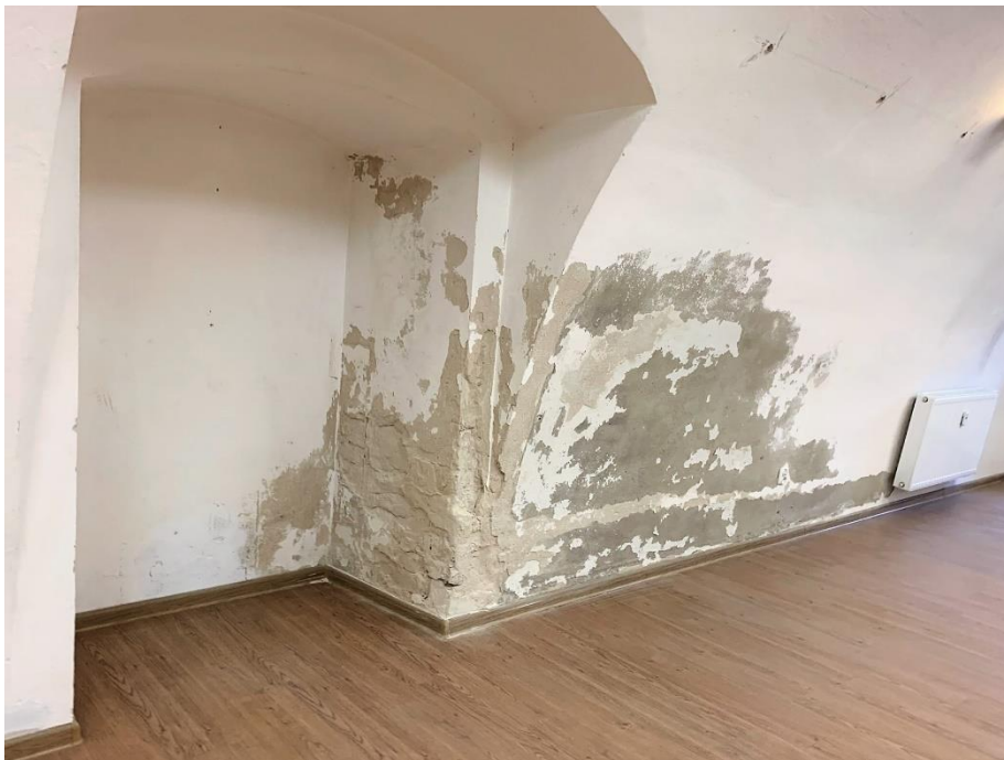
Złuszczone tynku i farba odsłaniająca fragmenty cementowego tynku
