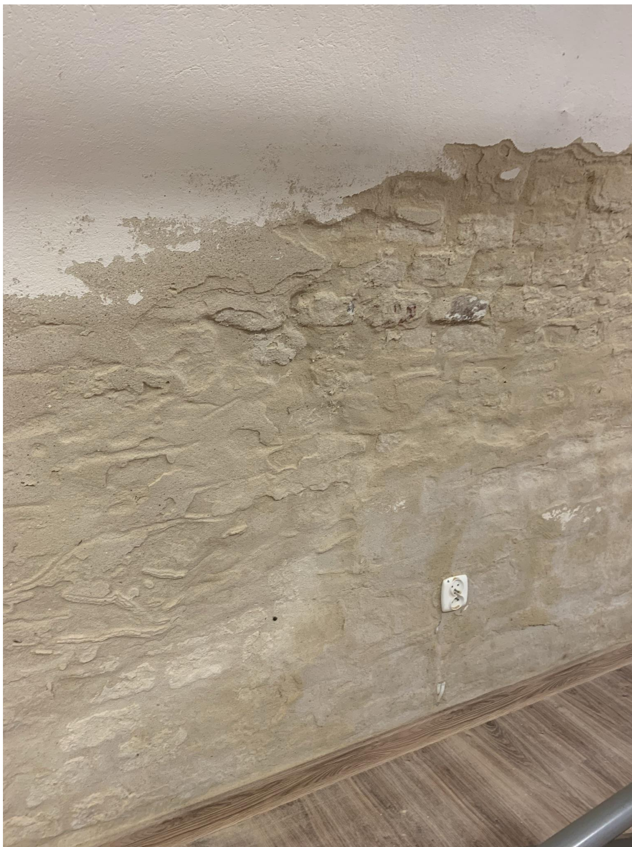
Odspojone tynki w jednym z pomieszczeń bastionu
