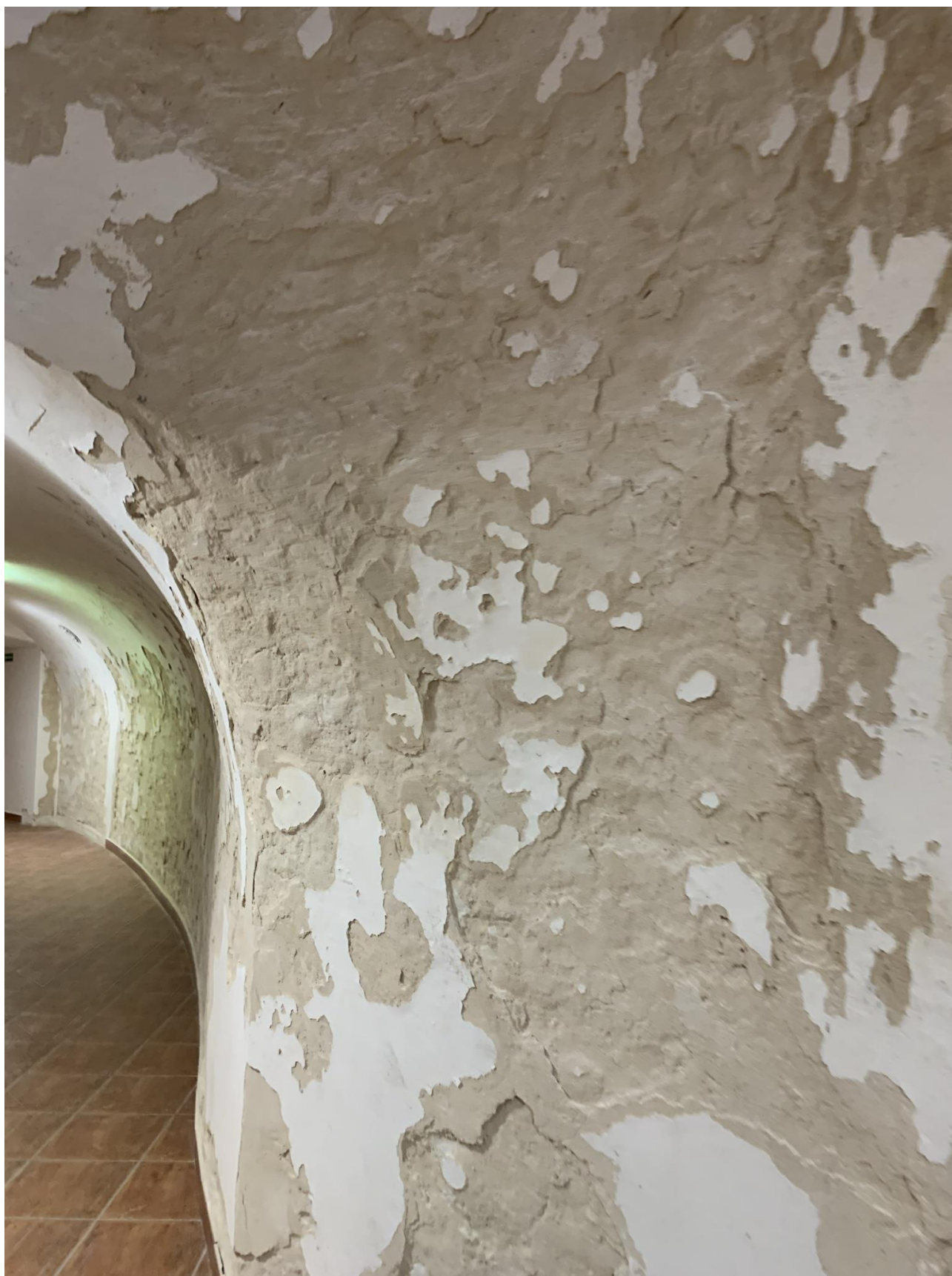
Odspajające się tynki na korytarzu
