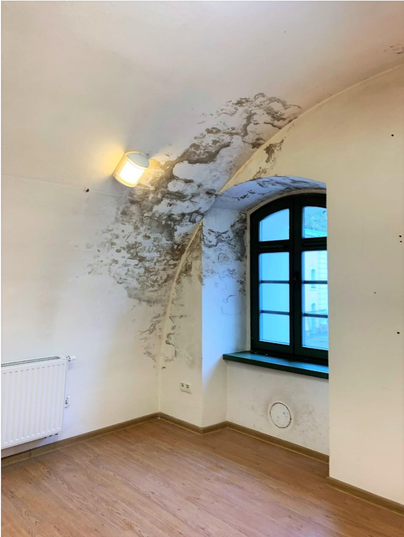
Wilgotna ściana porażona mikrobiologicznie
