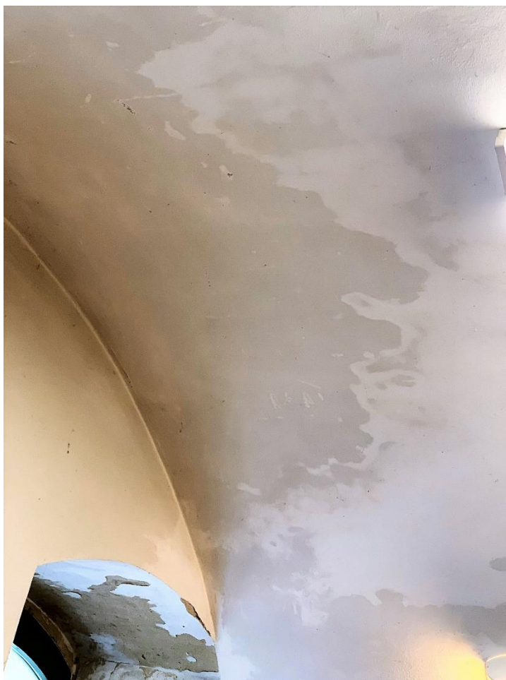
Widoczna wilgoć na ścianie jednego z pomieszczeń
