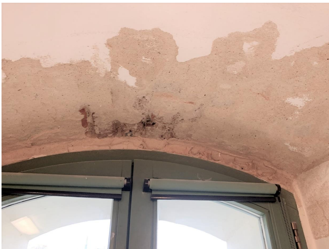
Ubytki tynku w glifie okienny
