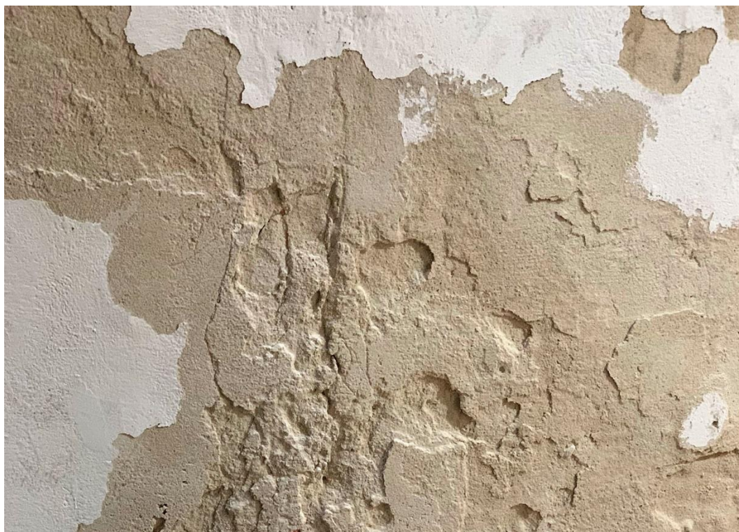
Zniszczenia tynków
