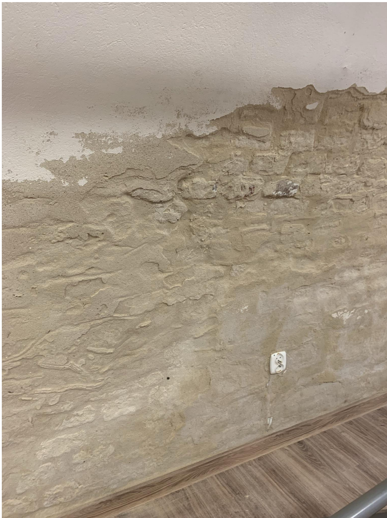
Odspojone tynki w jednym z pomieszczeń bastionu
