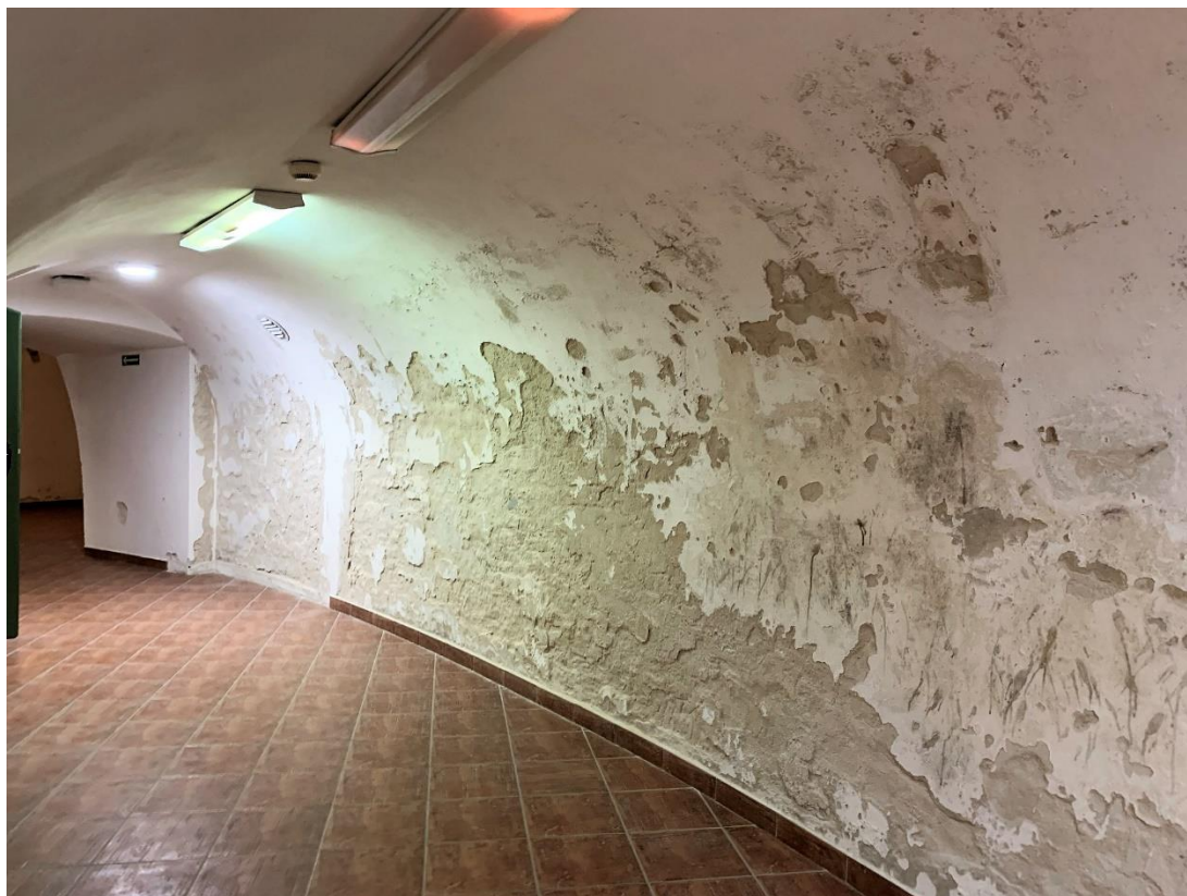
Fragment korytarza z odspajającymi się tynkami i wysoleniami
