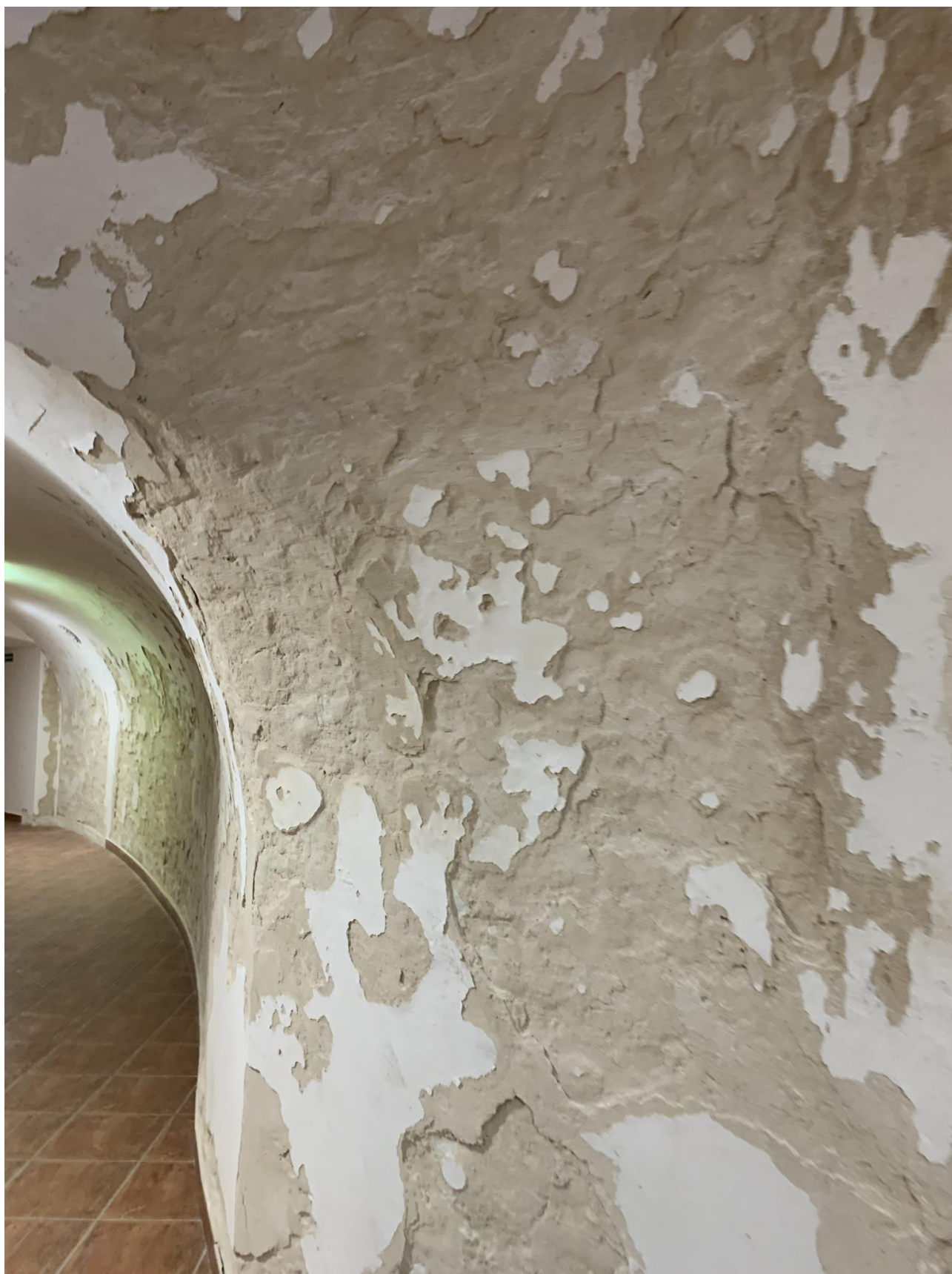
Odspajające się tynki na korytarzu
