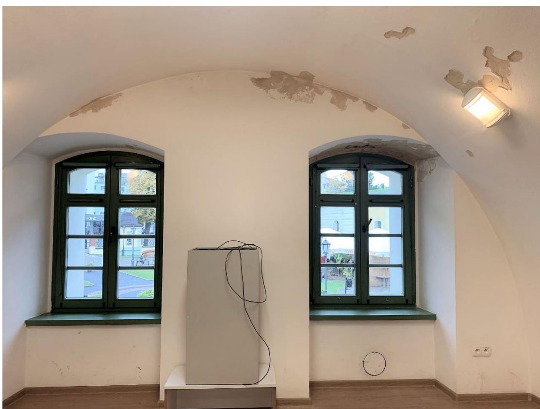
Zniszczenia tynków w jednym z pomieszczeń bastionu
