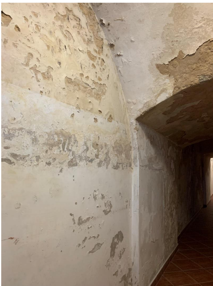
Zniszczenia tynków
