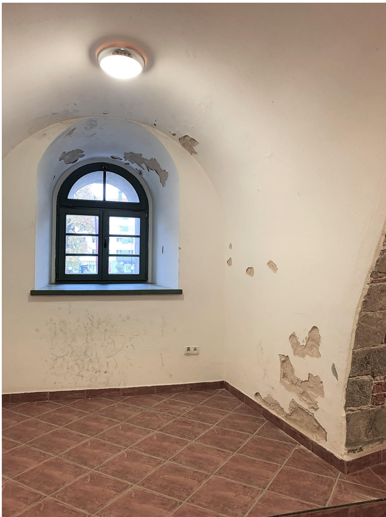
Odspajające się tynki
