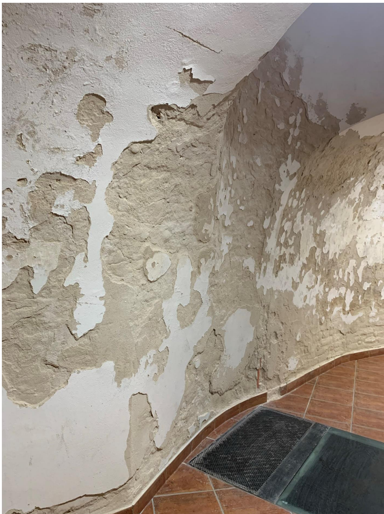
Fragment korytarza z odspajającymi się tynkami i wysoleniami
