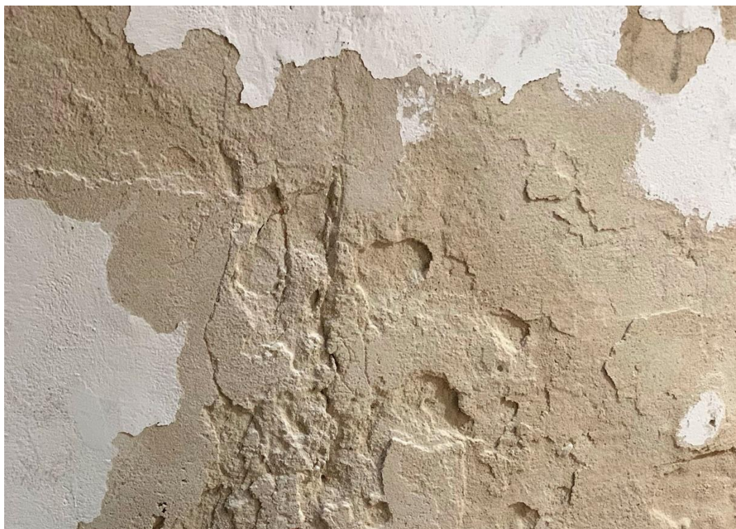
Zniszczenia tynków
