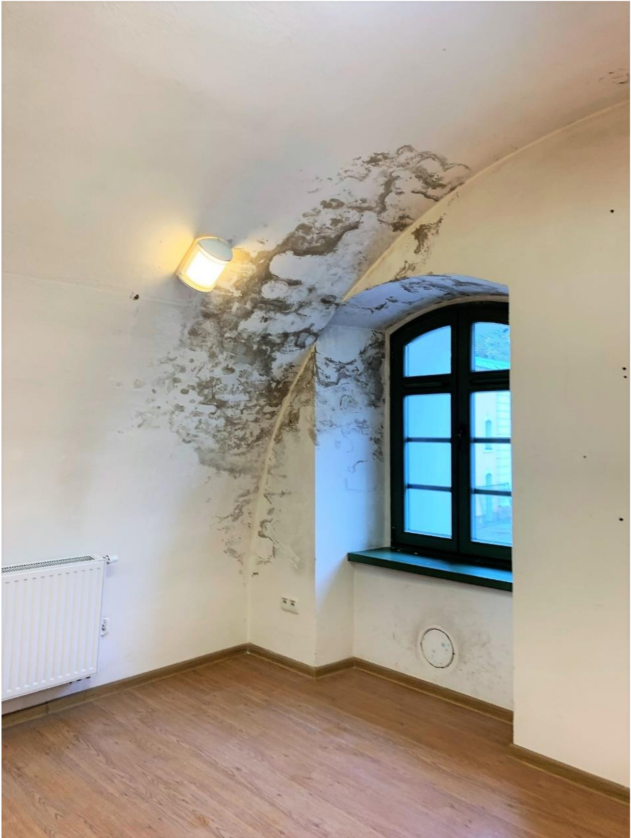
Wilgotna ściana porażona mikrobiologicznie
