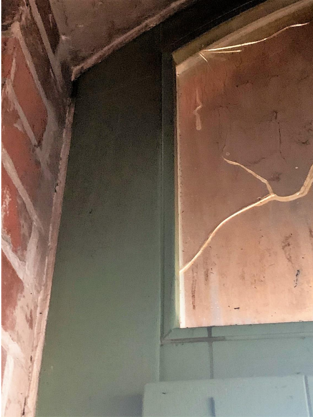
Fragment drzwi- zniszczenia stolarki i szklenia
