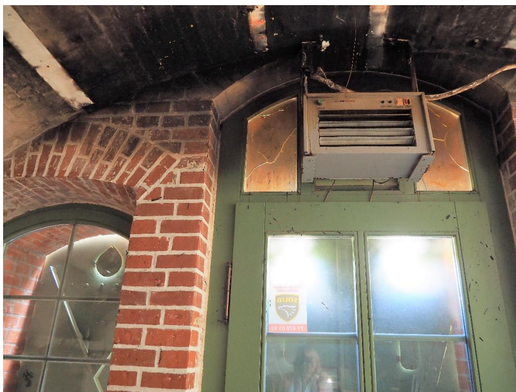
Fragment wnętrza po pożarze- drzwi i ściana ceglana- widoczne zabrudzenia sadzą
