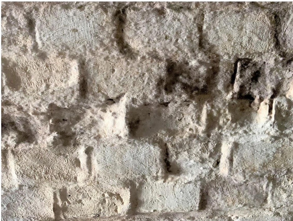
Widoczne wykwity pleśni na ścianie
