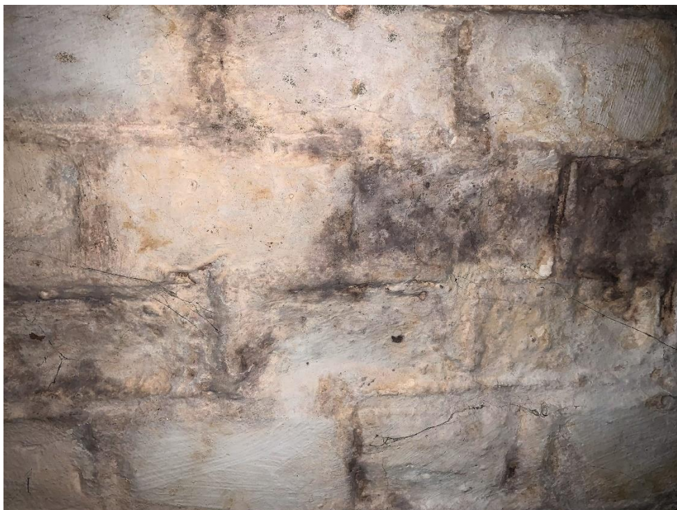
Widoczne zabrudzenia sadzą i żółte zaplamienia pobiałły
