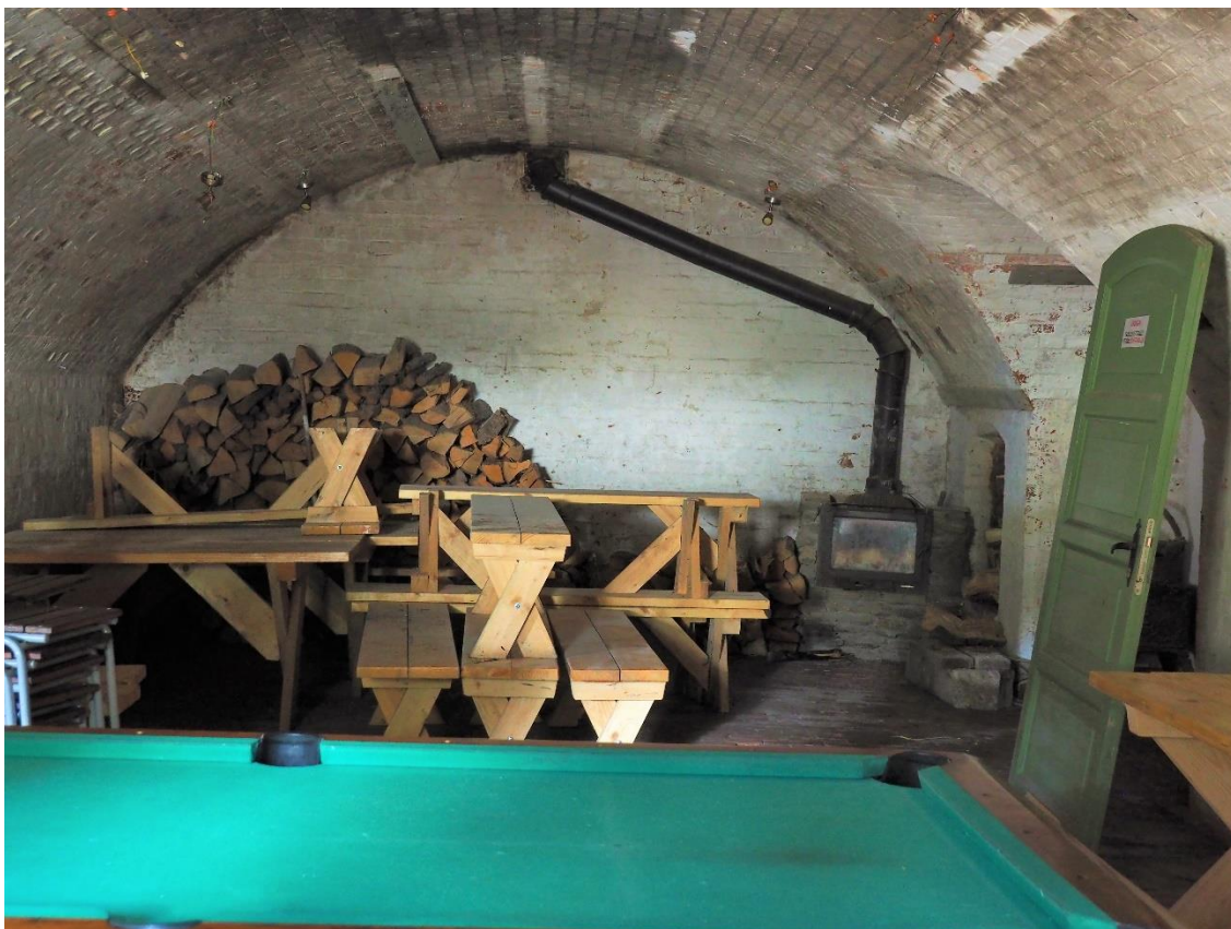
Fragment wnętrza po pożarze- widoczne zabrudzenia sadzą
