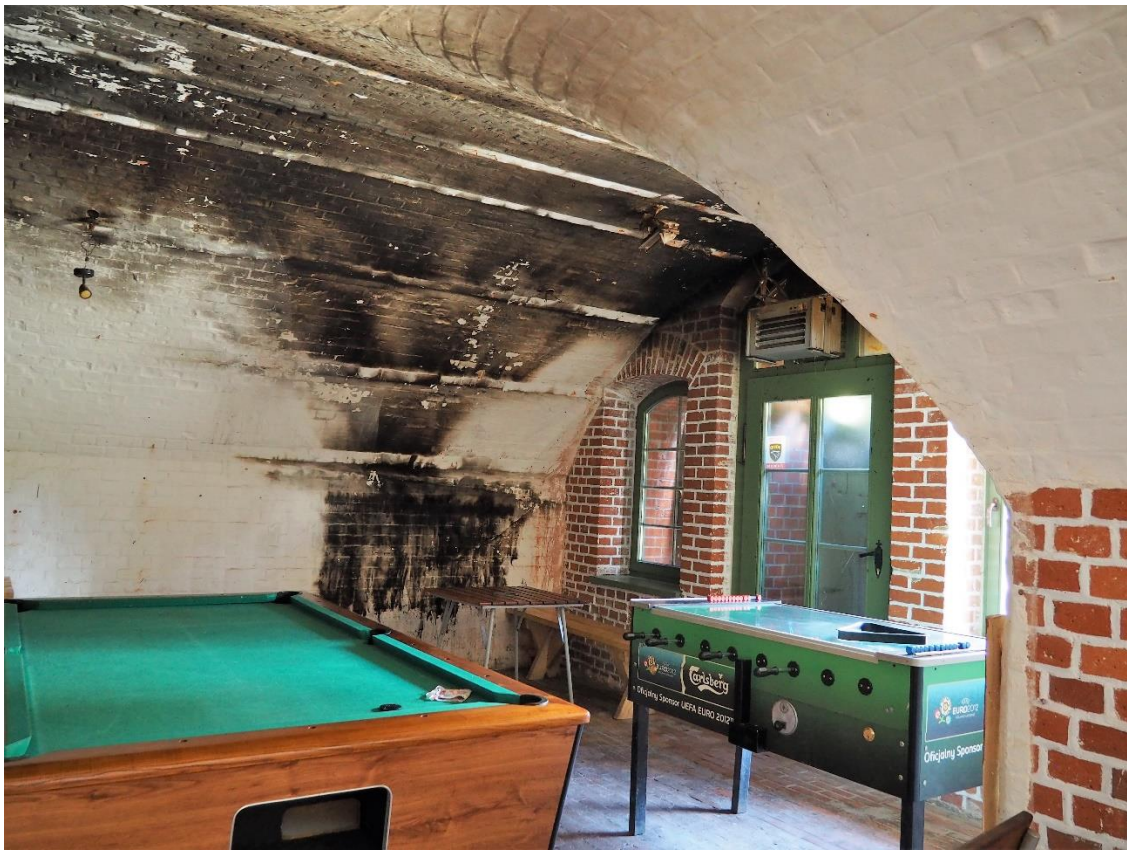
Fragment wnętrza po pożarze- widoczne zabrudzenia sadzą
